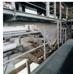
Kunststoffkette 310 und Edelstahlkette 45 montiert an der "Oresund Brücke" zwischen Schweden und Dänemark.
